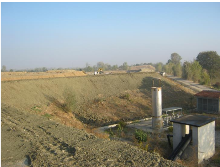
Foto 2 -argine a + 7,00 realizzato sui settori F1 e F2 al quale si deve raccordare la nuova sopraelevazione sul settore F3
